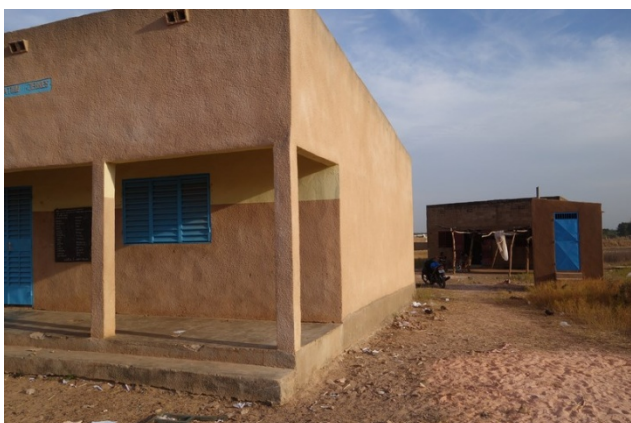
Nouvelle latrine ECOSAN du collège public
