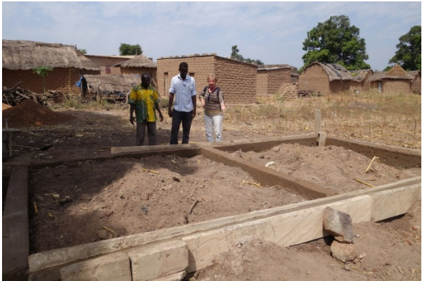
Visite à Ouolonkoto pour constater l'avancement des travaux de la boulangerie
